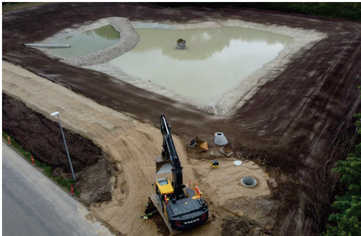
Foto fra anlægsarbejdet vedr. etablering af regnvandsbassin i Skjoldborg
