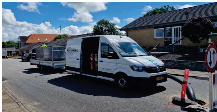
Foto fra anlægsarbejdet på Lunegårdsvej i Snedsted
