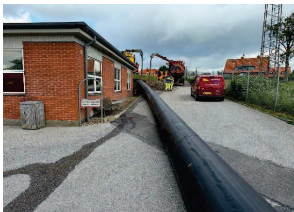
Fotos fra anlægsarbejdet vedr. etablering af regnvandsledning.
